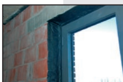
plaatsing met vouwfolie
